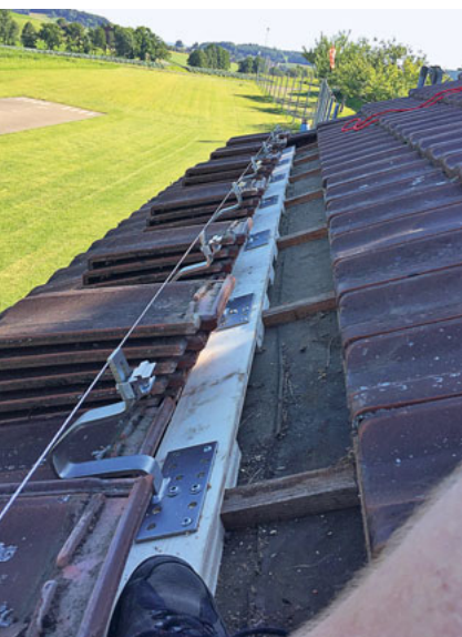
Unterbau für die Befestigung der Panels.
