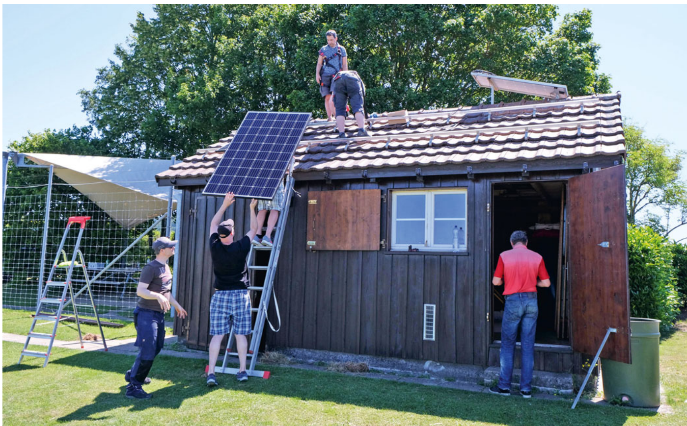
Montage der Solarpanels.
