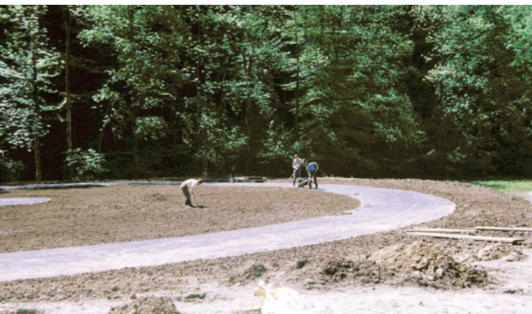
Bau «Schwalbennest»: Mit viel Handarbeit zum Ziel.
