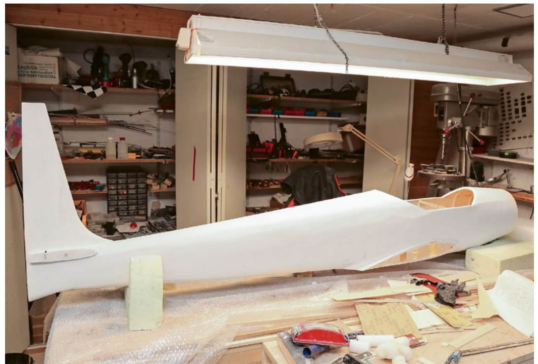
Glasmatte mittels Contur (Hydrofüllgrund) auf Rumpf aufgetragen.
