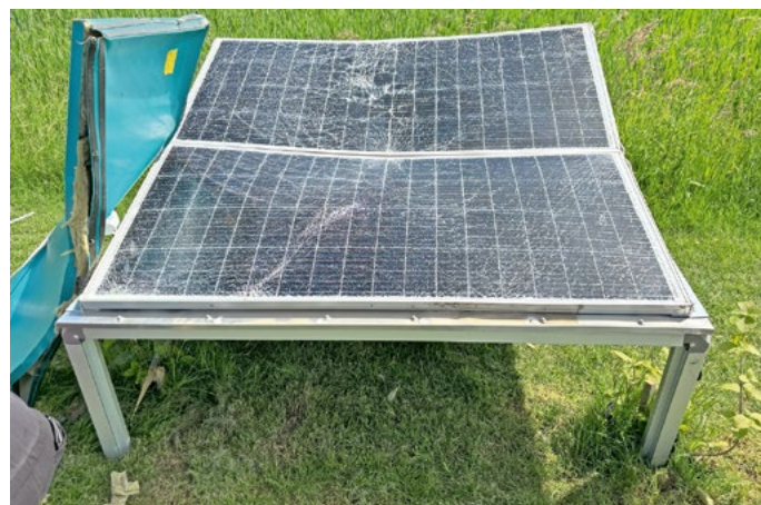
Die zerstörten Solarpaneele.
