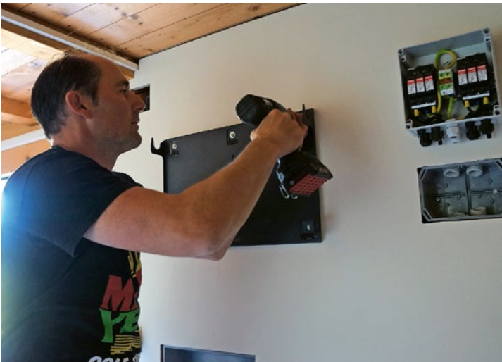
Marco bei der Montage der Halteplatte für den knapp 25 kg schweren Wechselrichter.
