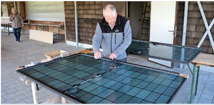
Günther, Ehrenpräsident der MFGL, kümmert sich um die Montage der PV-Optimierer und die Vorbereitung der Panels vor der Montage auf dem Dach. Die PV-Optimierer kompensieren Panels, welche durch Abschattung weniger Leistung liefern.
