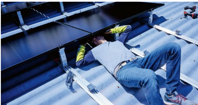
Die 26 Panels sind in zwei Stränge mit je 13 Panels aufgeteilt. Dominik kümmert um die elektrische Verbindung zwischen den Panels. Gewisse Arbeiten verlangten ganzen Körpereinsatz.
