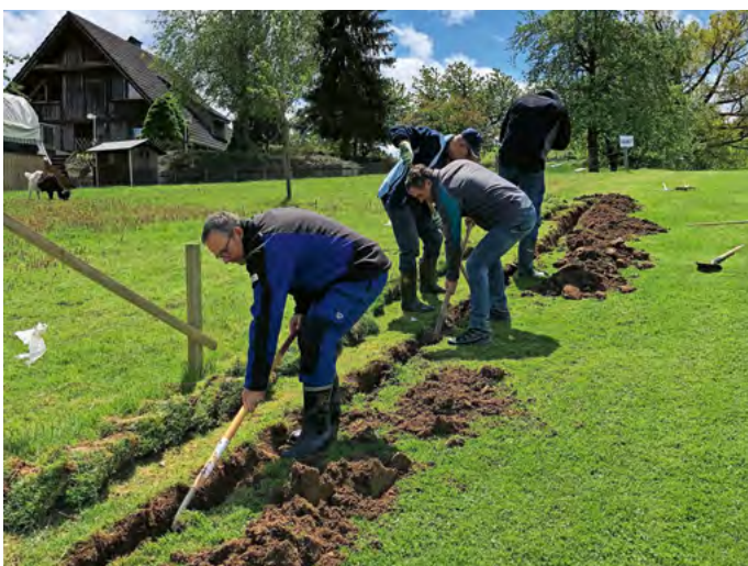
Freiwillige Helfer aus dem Verein beim Verlegen des Stromkabels.
