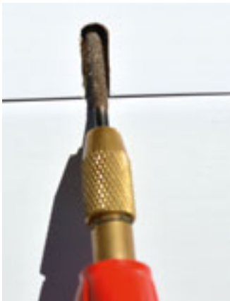
Überall ist der Gestänge-durchbruch nachzuarbeiten.
